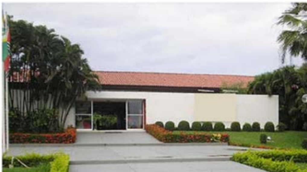
Imagem 03 –Entrada da Escola Fundação Privada
